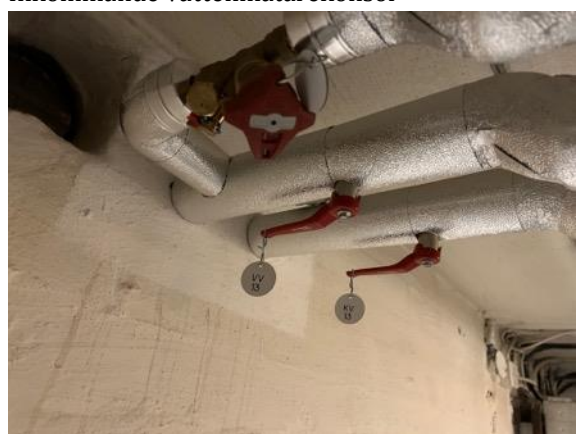
Nyare ventiler tappvattenstråk
