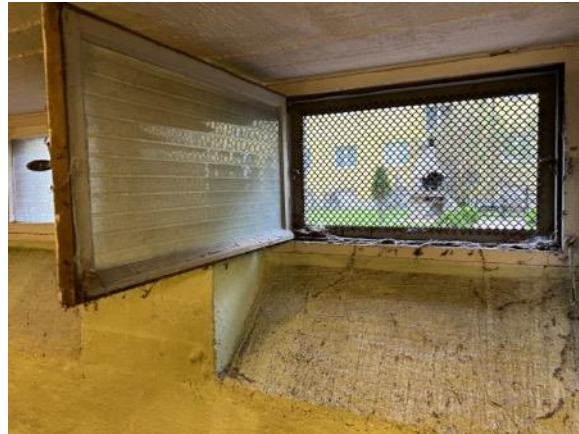
Källarfönster målningsbehov invändigt/mellan
