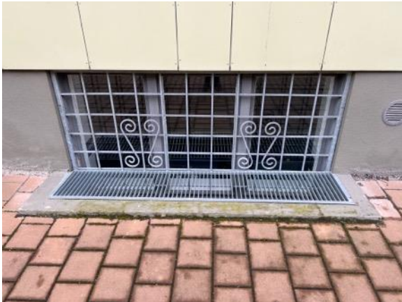
Källarfönster med inbrottsgaller mot tvättstuga
