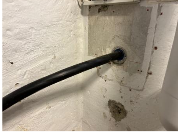
Ny servisledning el i UC
