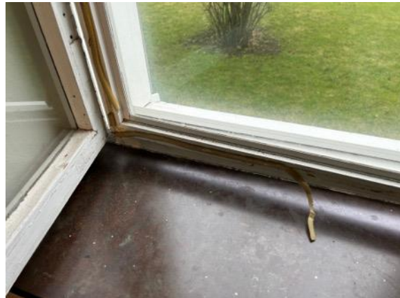
Målningsbehov och släpp dammtätninglister
