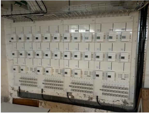
Lägenhetsmätare placerade i UC
